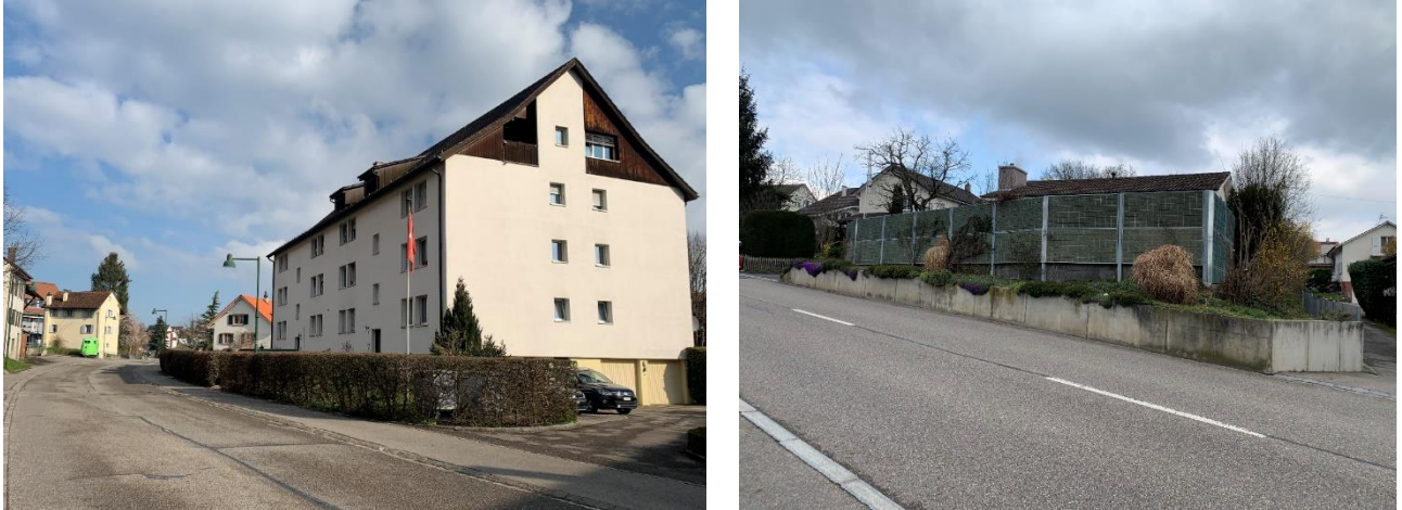
Abbildung 7: Mehrfamilienhaus (links) und Lärmschutzwand eines Einfamilienhauses entlang der Bättwilerstrasse (rechts)
