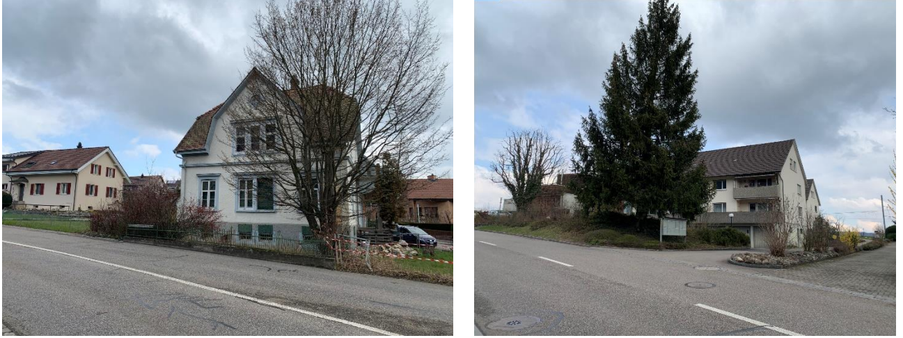
Abbildung 26: Das erhaltenswerte Gebäude bei der Einmündung Bättwilerstrasse – Weisskirchweg (links) und Mehrfamilienhaus entlang der Bättwilerstrasse (rechts)
